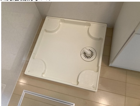
8.洗濯機防水パン
