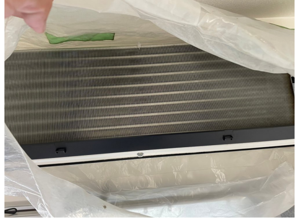
17.エアコンクリーニング
