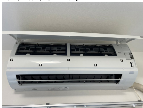
17.エアコンクリーニング
